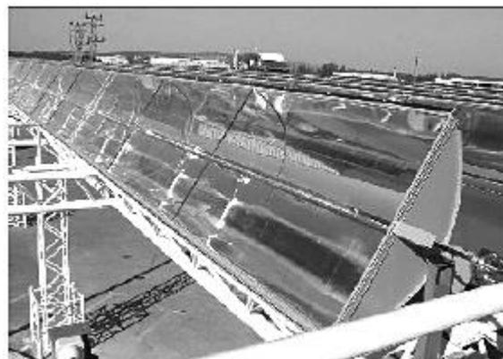
Considerando que a distância entre a borda inferior e a borda superior da superfície refletora tenha 6 m de largura e que focaliza no receptor os  $800 \text{ watts/m}^2$  de radiação provenientes do Sol, e que o calor específico da água é  $1 \text{ cal. g}^{-1} \text{ } ^\circ\text{C}^{-1} = 4.200 \text{ J. kg}^{-1} \text{ } ^\circ\text{C}^{-1}$ , então o comprimento linear do refletor parabólico necessário para elevar a temperatura
